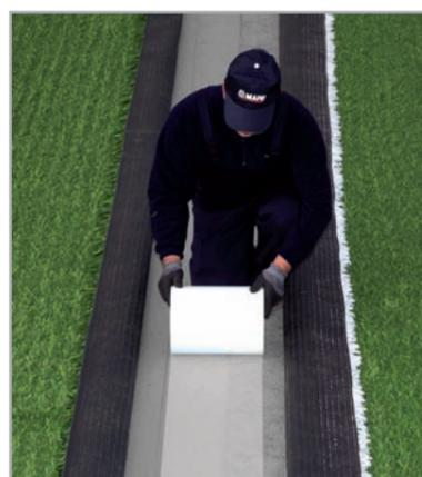
Stesura della banda di giunzione ULTRABOND TURF TAPE 100
