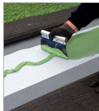
Stesura dell'adesivo su ULTRABOND TURF TAPE 100 mediante spatola dentata
