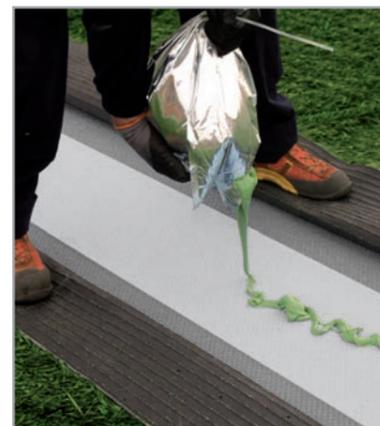
Applicazione di ULTRABOND TURF PU 1K sulla banda di giunzione mediante estrusione dal sacchetto di alluminio
